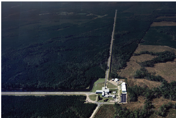
Figura 4. Foto aérea do laboratório LIGO localizado em Livingston, no estado da Louisiana, EUA.
